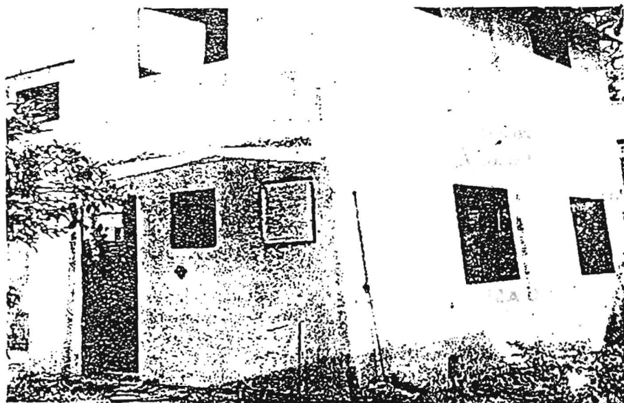
Con ferrocemento (como el empleado para construir em- barcaciones), han edificado un grupo inicial de 6 casas como éstas, en Cárdenas, provincia de Matanzas.
