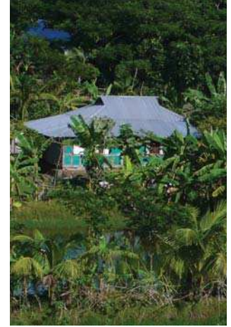
Bangladesh arbres coupe-vent toiture à quatre pentes système paracyclonique
