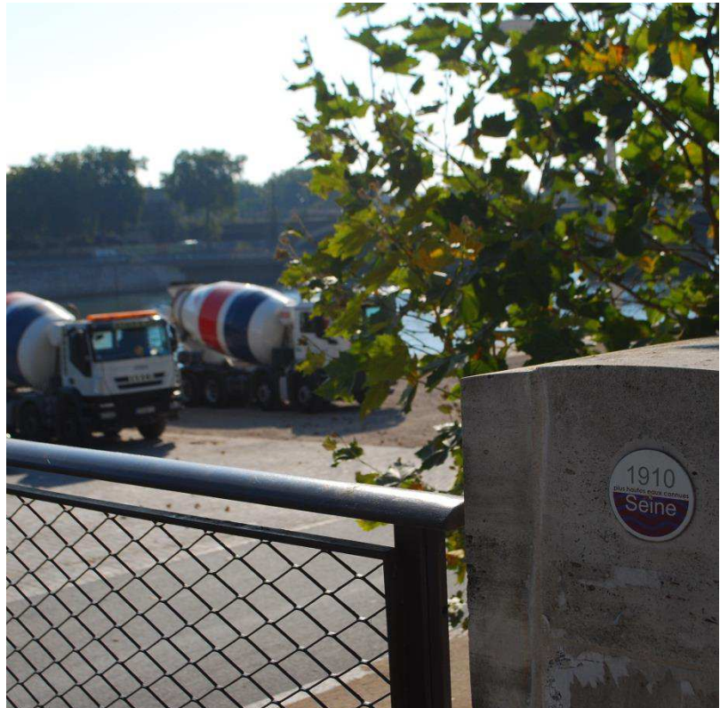
Photo 4 : Repère de crue sur le mur anticrue du quai Panhard et Levassor
