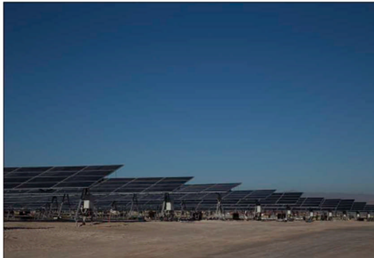
PLANTA FOTOVOLTAICA EN LA REGIÓN DE ANTOFAGASTA 2015 | CHILE 160MW
