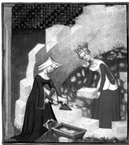
Mulheres pedreiras construindo o muro de uma cidade, século XV.
