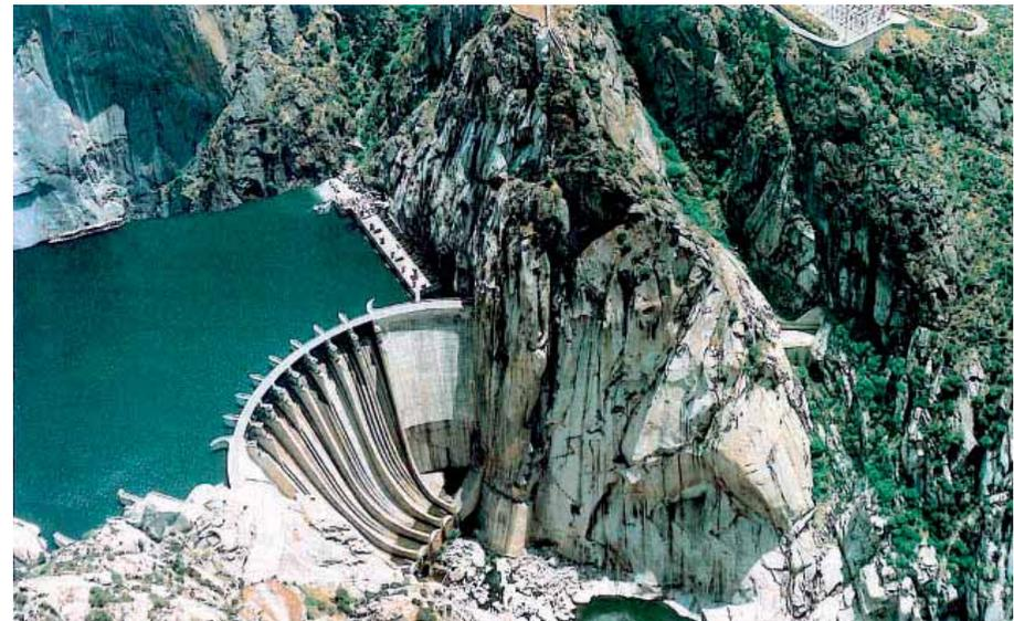
ALDEADÁVILA es una presa de arco-gravedad extraordinariamente bien encajada en su emplazamiento. Es la presa de arco gravedad más alta de España y, sin duda, una de más bellas. Forma parte del conjunto de presas construidas para el aprovechamiento del Duero, que en su diseño, construcción y explotación fueron una epopeya.
