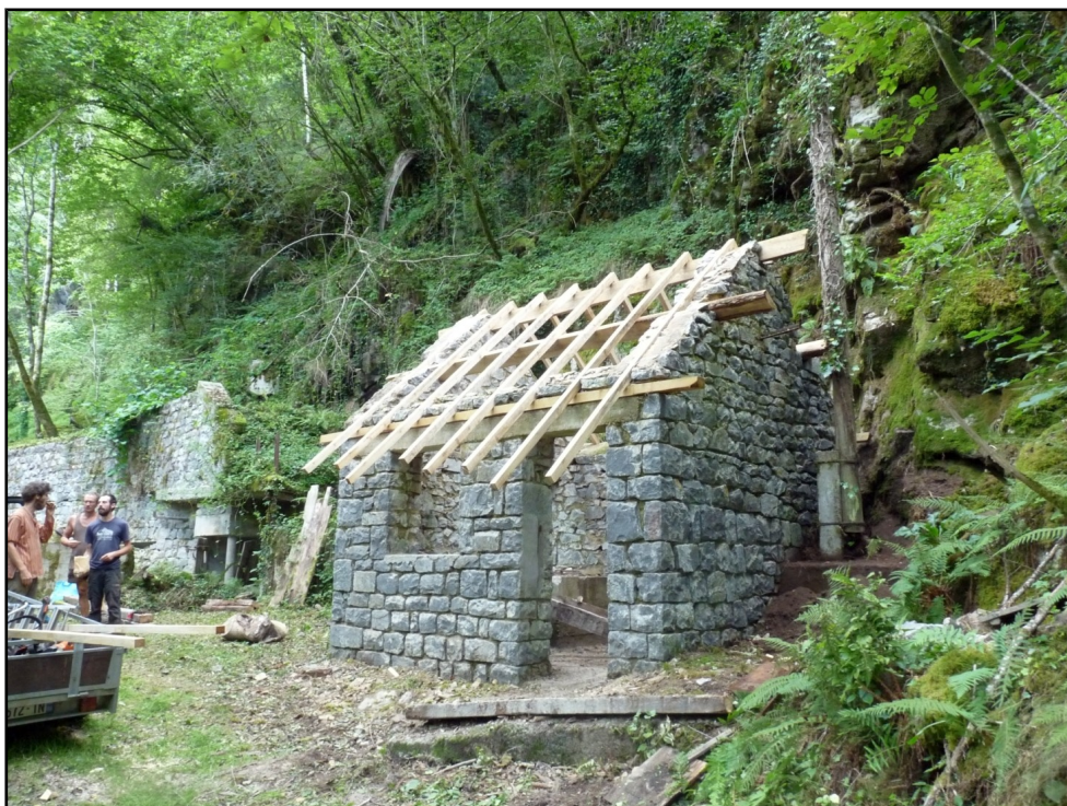
La cabane avec sa nouvelle charpente
